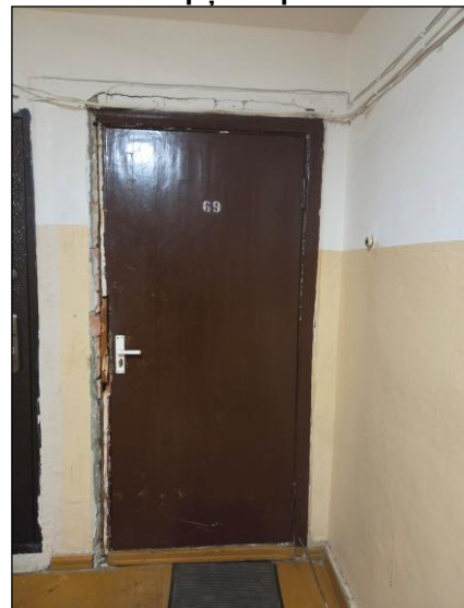
Kāpņu telpas (dzīvokļa ārdurvis)
